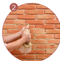
Je réalise les joints
